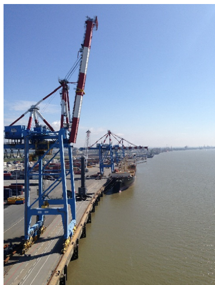
Fig. 7 : Diagnostic des voies de roulement du chariot qui décharge les conteneurs des bateaux. Port de Saint-Nazaire.
