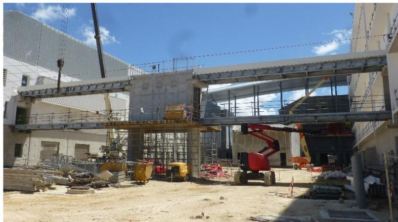
Fig. 5 : Réception de 2 passerelles pour la pose des façades, CHU Pointe-à-Pitre, Guadeloupe.
