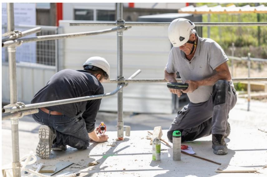
Fig. 8 : Implantation au mini-prisme d'un support de mur-rideau. Bâtiment de bureaux, Zac de Groues, Nanterre.
